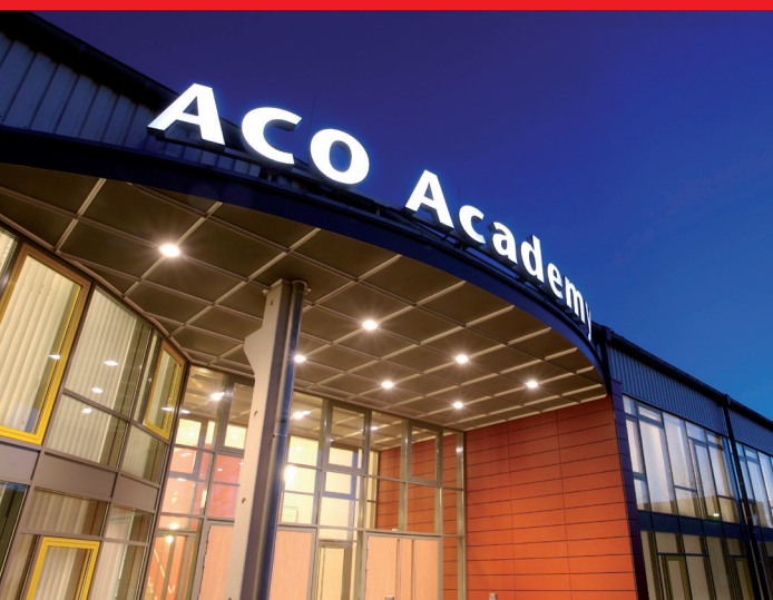
Die ACO Academy in Büdelsdorf/Rendsburg
